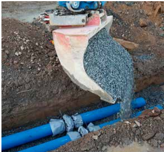
Wiederverfüllung mit Schotter (8 - 16 mm)
